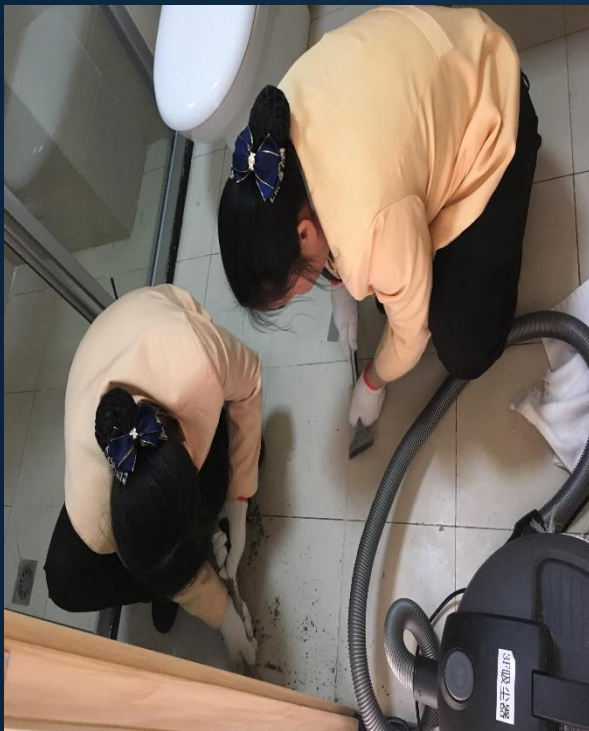
3号楼卫生间已经完成了地面 瓷砖勾缝打胶
